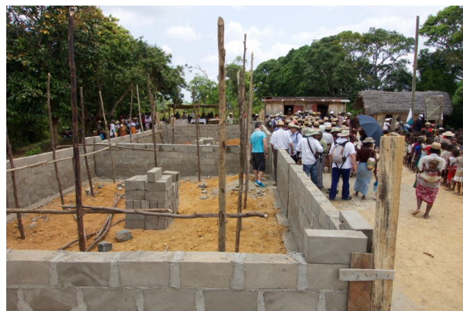
Photo.-Une école en cours de construction dans la brousse à Andemaka. www.l-h-m.org
