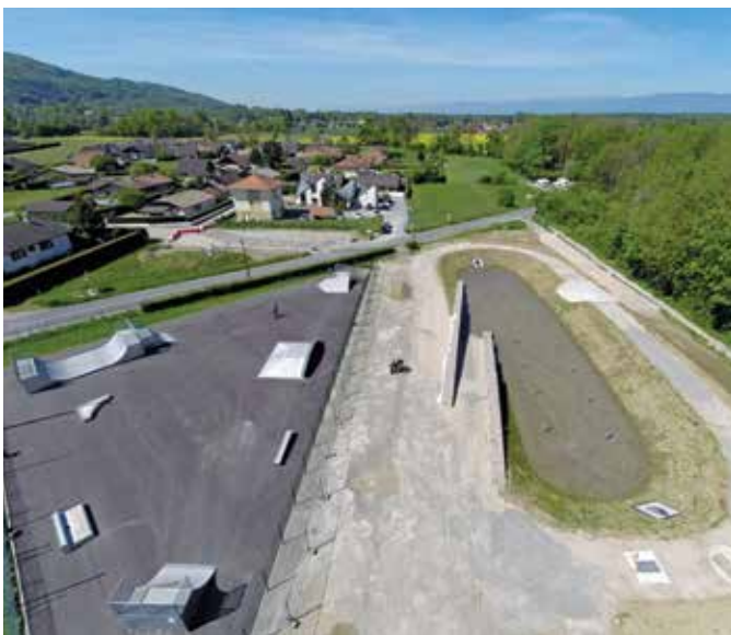
Le skate park et le bac de décantation de la nouvelle voirie
