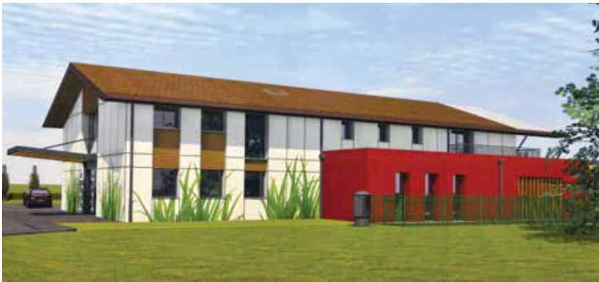
La crèche sera achevée en septembre 2015 ; le chantier avance rapidement
