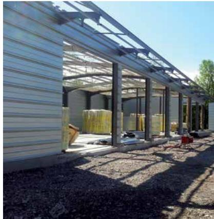
Le centre technique sera composé dans l'immédiat d'un bâtiment de 700 m<sup>2</sup> pour le rangement des véhicules et engins divers et d'un deuxième hangar de 200 m<sup>2</sup> pour stocker tout le matériel événementiel.
