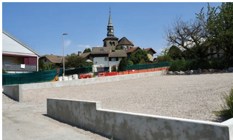
Création du nouveau parking
