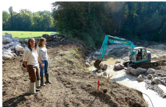
Photo. Marine Gleize, ici avec Marie-Pénélope Guillet, conduit les travaux pour le Symasol
